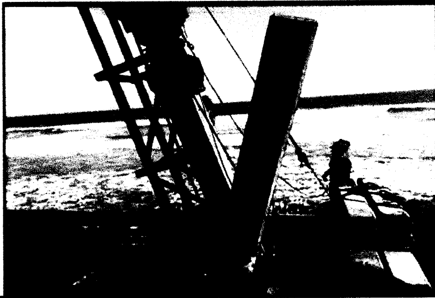
Imagen N°03.- Hincado de pilotes inclinados de reforzamiento de estructura de muelle.
